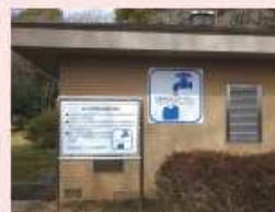
震災対策用応急給水槽 地下に1,500m³の新鮮な水が蓄えられています。災害時に断水した際、水を配る場所となります。
