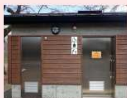
防災トイレ（常設） 地下にピット室を設けており、災害時には便槽として使えるようになります。
